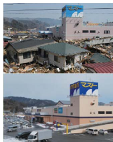
被災後の施設外観 （上段：H23. 3、下段：H23. 12）
